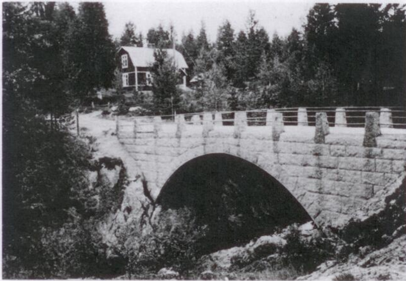
Bron över Aspsseleforsen byggdes 1871.
