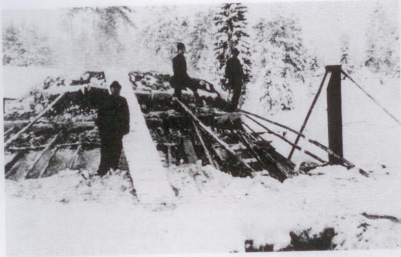
Runt om i socknen kolades förr många kolmilor. Denna bild är från Nyliden.
