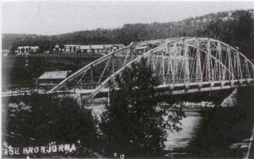
Järnbro över Gide älv, byggd 1903. Den är nu riven och ersatt med en betongbro.
