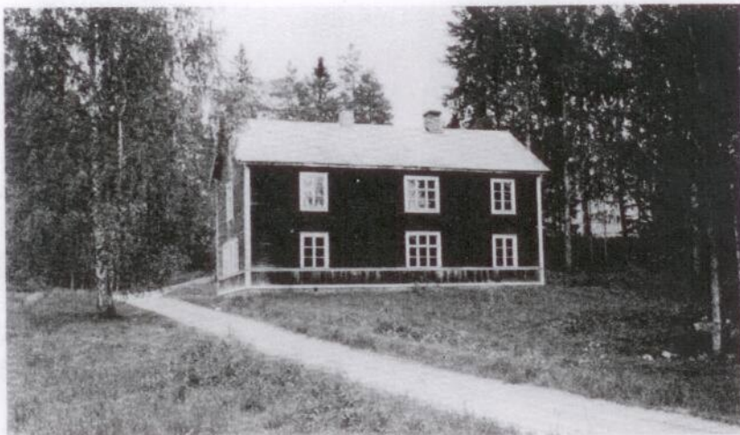
Gamla skolan i kyrkbyn är socknens äldsta skolhus och uppfördes åren 1847–1848. Genom ombyggnader har exteriören förändrats. I början av 1850-talet användes fastigheten till kyrkolokal, och under många år hade skolan sina lokaler här. Den har även varit kommunalhus och bostadsfastighet, och nu nyttjas den som militärförråd.
